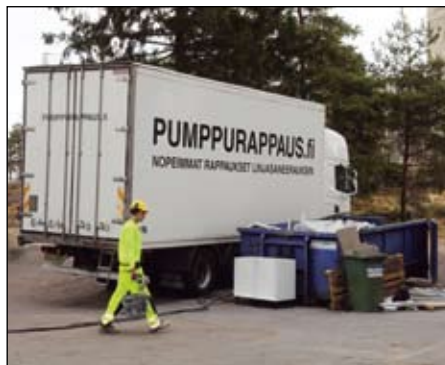
Kuorma-auton konttiin rakennettu korkeapainepumppu ja laastin sekoitusyksikkö toimivat täysin automaattisesti.
