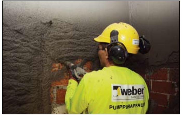
Paksutkin täytöt saadaan kerralla tehtyä nopeasti kovettuvalla kuituvahvisteisella Märkätilalaastilla.
