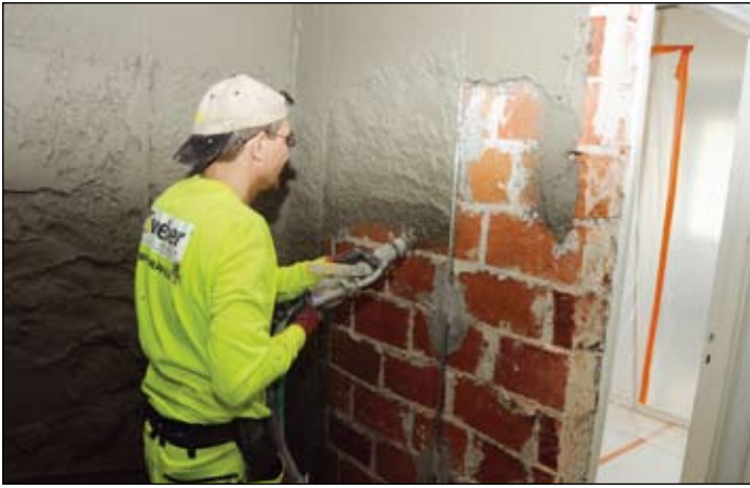
Pumppurappaus on nopeaa, pölytöntä ja ergonomista. Korkeapainerappauksen paine riittäisi jopa Näsinneulaan.
