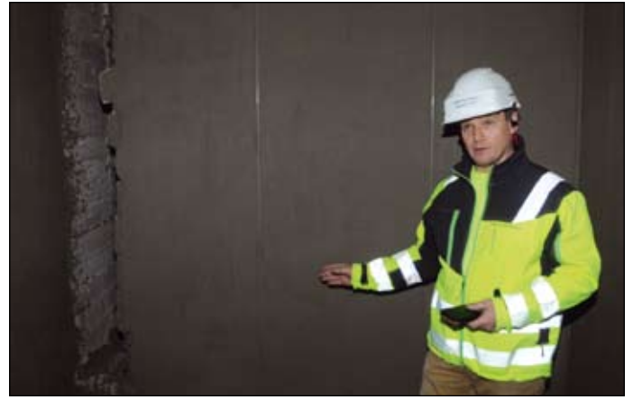
Yrittäjä Jari Jokila esittelee seinäpintaa, joka on valmis veden-eristettäväksi ja laatoitettavaksi jo kahden päivän kuluttua.
